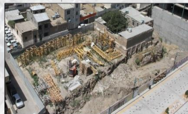
قسمتی گود برداری شده ( متوقف )
