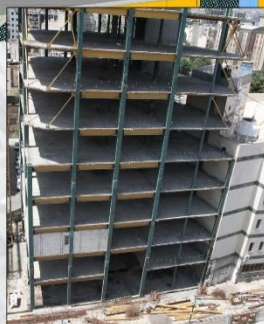
در حال ساخت ۱۰ طبقه روی زمین ( اسکلت )
