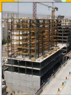
در حال ساخت ۱۰ طبقه روی زمین ( اسکلت )
